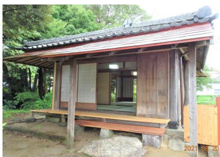
【入口付近（東北側より）】
