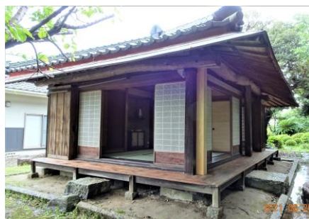
【全景（南西側より）】
